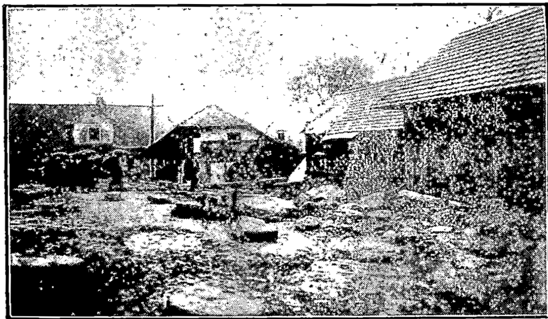
Сл. 1. Поплава у Словеначној. Набујала вода донела је велико камење, које је оштетило и разрушило куће.
